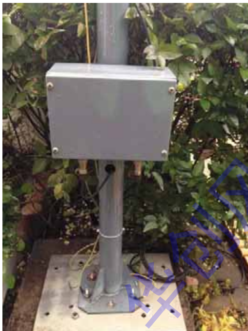
安装电源控制箱
